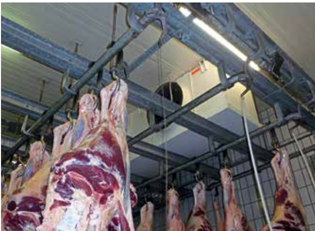
Innerhalb von zehn Stunden wird das Fleisch von Schlacht- auf 2 °C Lagertemperatur abgekühlt.
