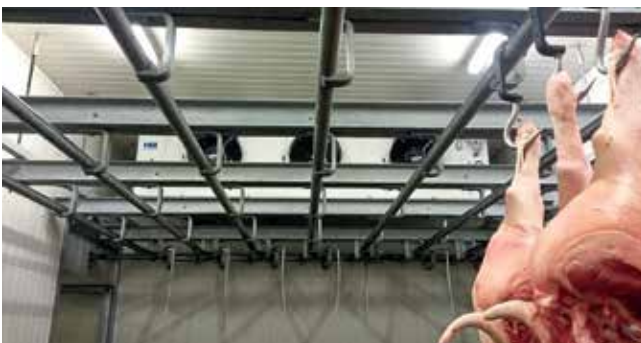
Die Deckenluftkühler mit großen Oberflächen entfeuchten und kühlen damit schneller als mehrere kleine.
